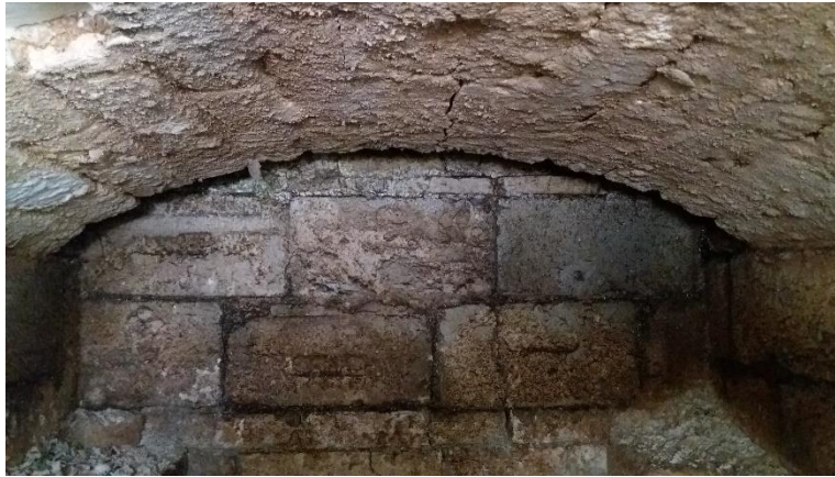
Figura 2. Bóveda del hogar. Al fondo se ve la boca de salida de las llamas.
