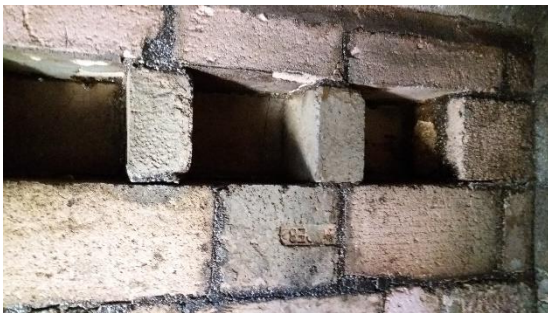
Figura 3. Bocas de los canales de fuego de la parte izquierda del horno. Estas bocas están situadas en la parte superior de la cámara de cocción.
