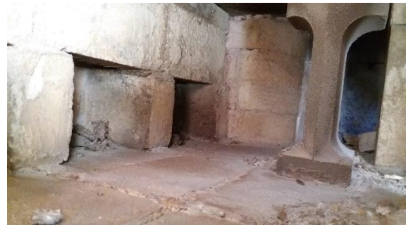
Figura 4. Salidas al pozo colector de los canales de fuego de la parte izquierda del horno. Al fondo está situada la base de la chimenea.
