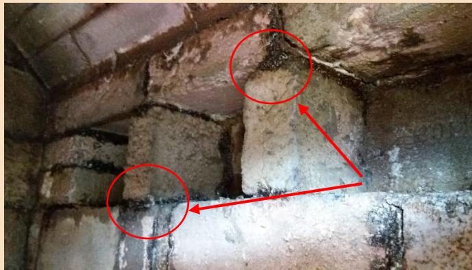
Figura 3. Ataque químico causado por la ceniza en un horno de leña. Fotografía: Rafa Galindo .
